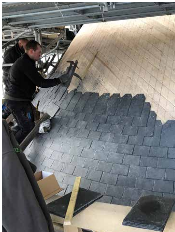
Sur l'abside, la pose des ardoises se fait au clou de cuivre
